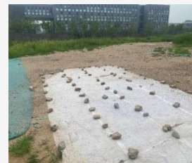
建筑工地防尘布
