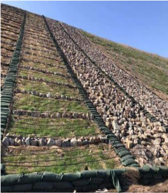
内蒙乌海骆驼山排土场生态修复技术模式
